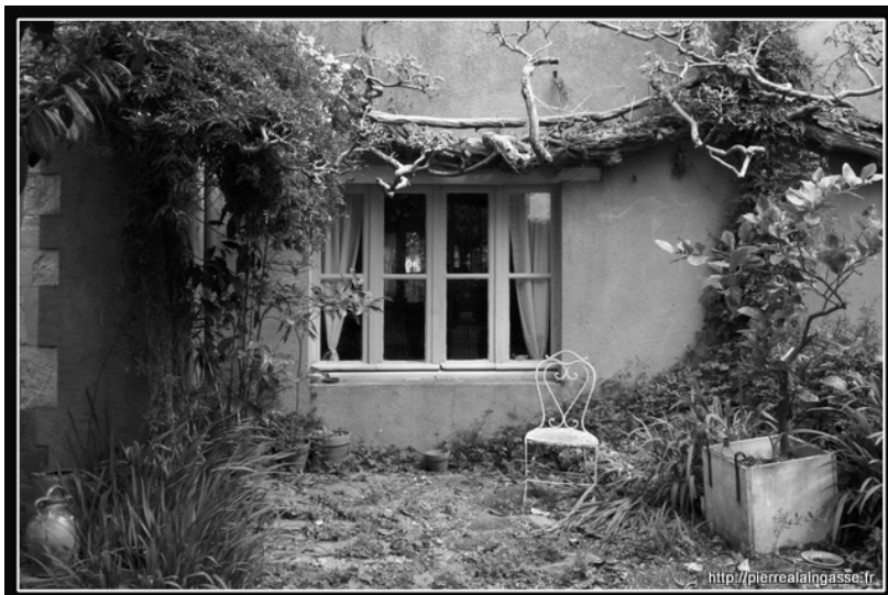
Façade - Noirmoutier ©B. Vauléon, 2010.
